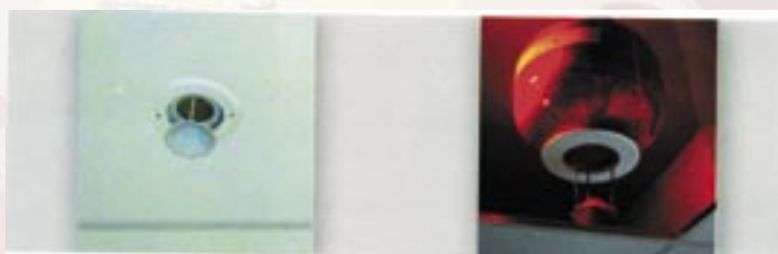
Размещение модуля «Буран-8» на подвесном потолке
